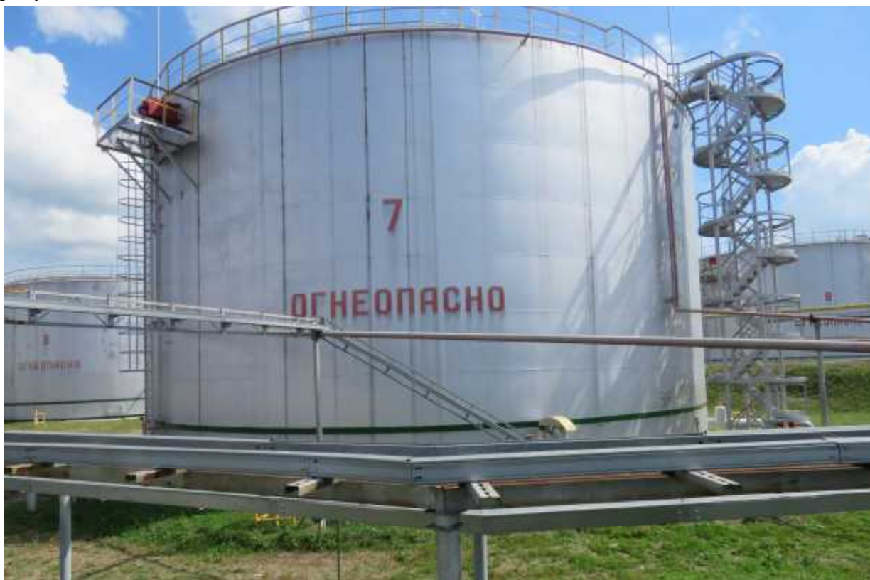
Рисунок 1 - Общий вид резервуара РВС-5000
