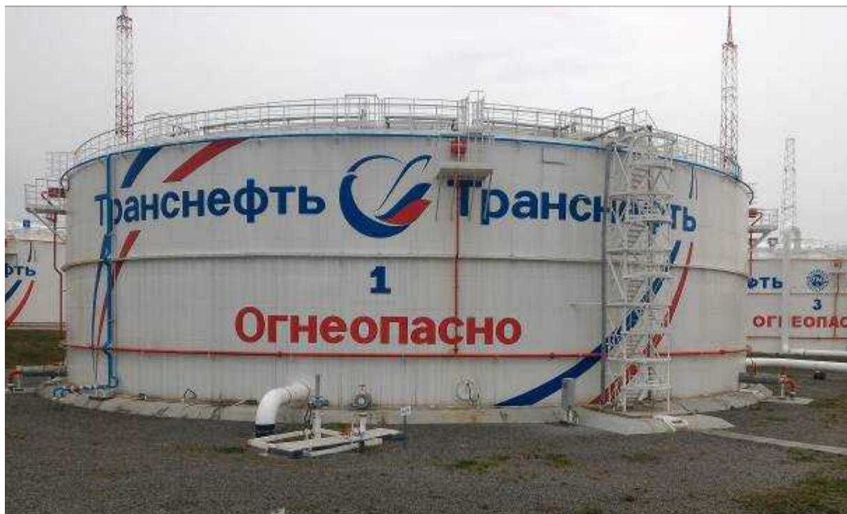
Рисунок 1 - Общий вид резервуара вертикального стального цилиндрического РВС-20000
