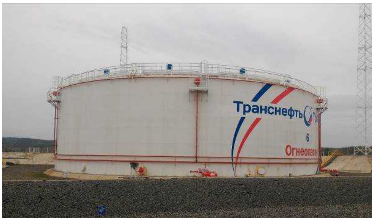
Рисунок 2 - Общий вид резервуара вертикального стального цилиндрического RVSP-20000
