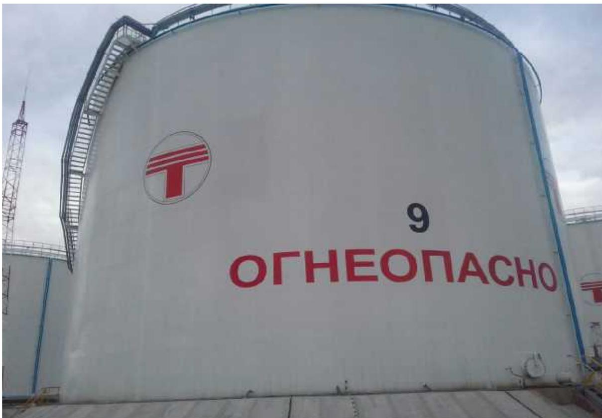
Рисунок 1 - Общий вид резервуара вертикального стального цилиндрического РВС-10000
