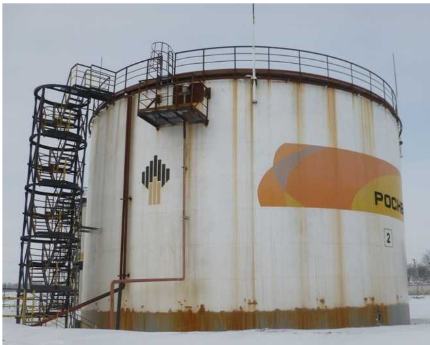
Рисунок 1 - Общий вид резервуара РВС-3000
