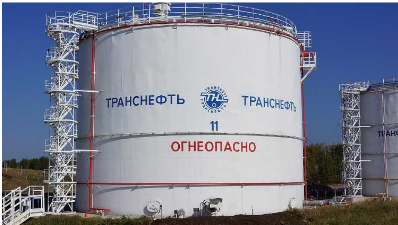
Рисунок 1 - Общий вид резервуара вертикального стального цилиндрического РВС-5000
