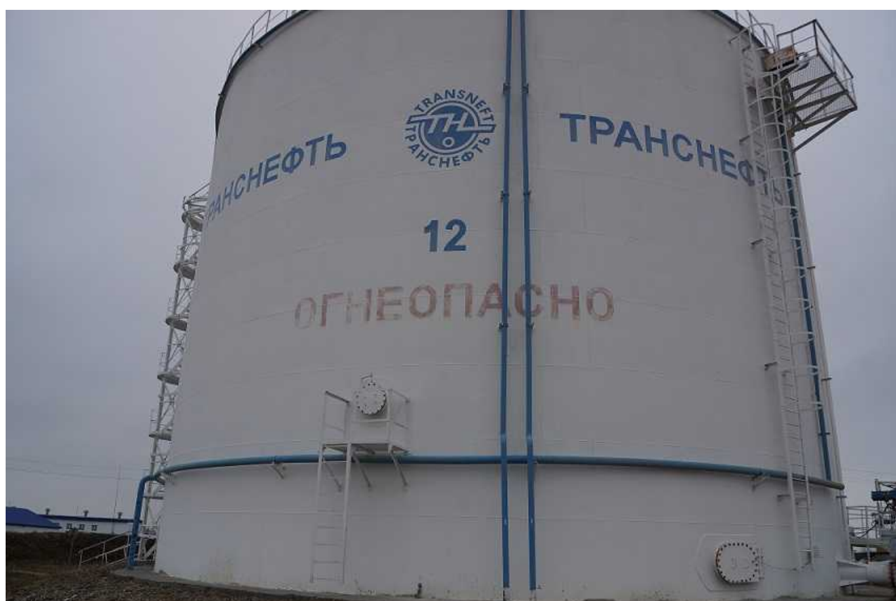
Рисунок 2 - Общий вид резервуара вертикального стального цилиндрического РВСП-5000
