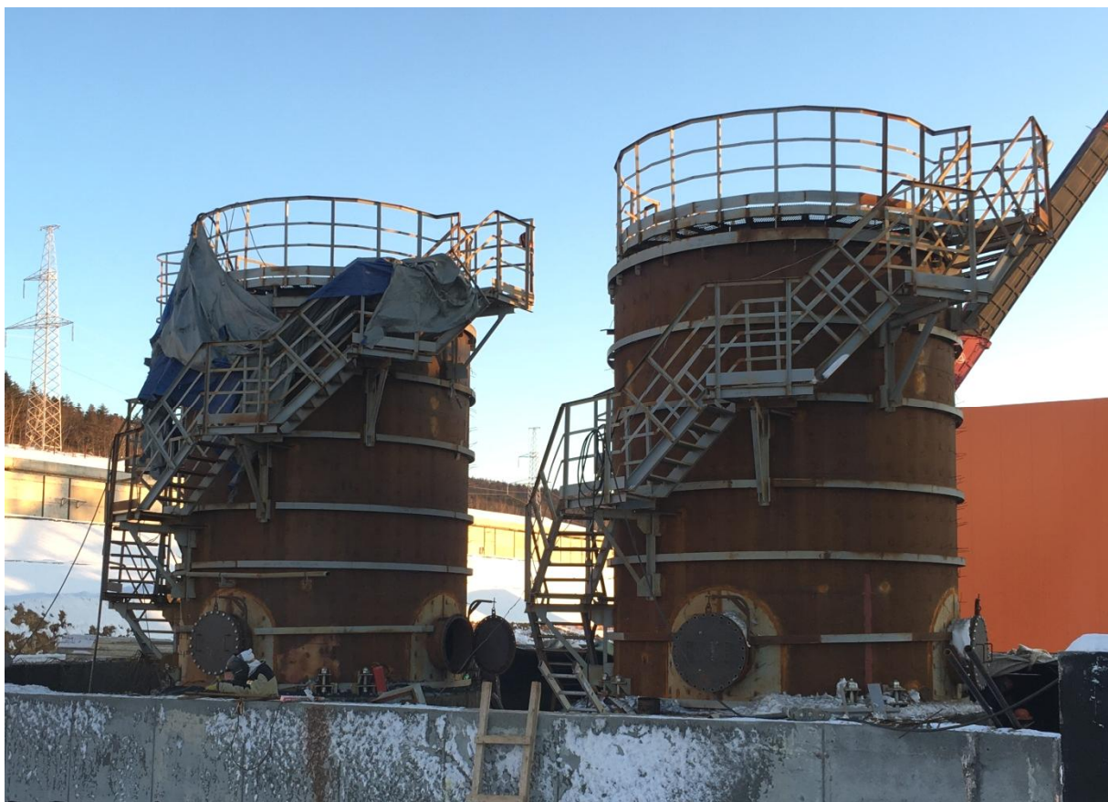
Рисунок 1 - Общий вид резервуаров
