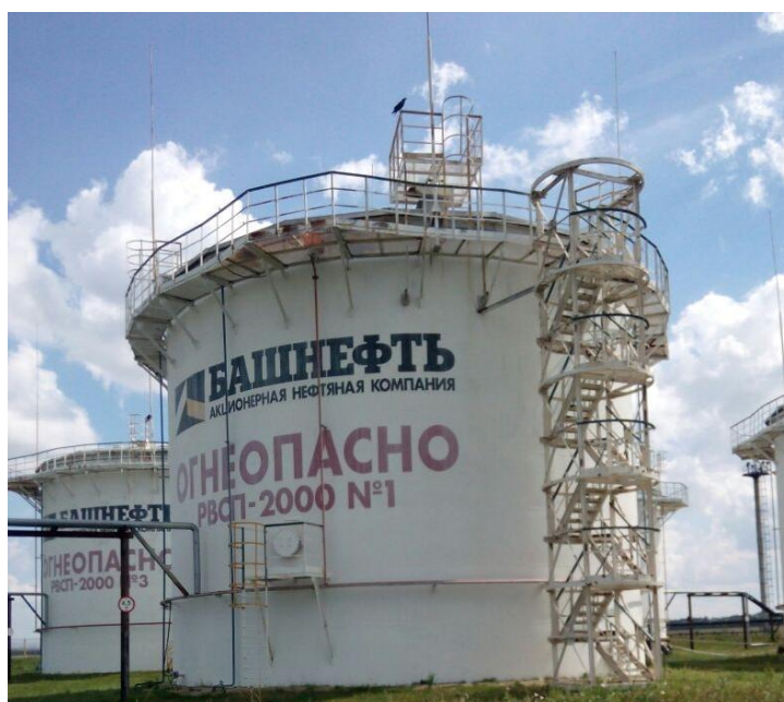
Рисунок 1 - Общий вид резервуаров стальных вертикальных цилиндрических с понтоном РВСП-2000
