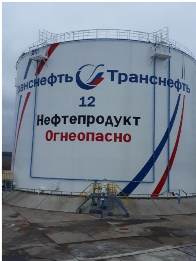
Рисунок 2 - Общий вид резервуара вертикального стального цилиндрического РВС-10000
