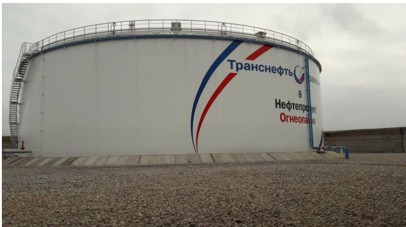
Рисунок 3 - Общий вид резервуара вертикального стального цилиндрического РВС-20000
