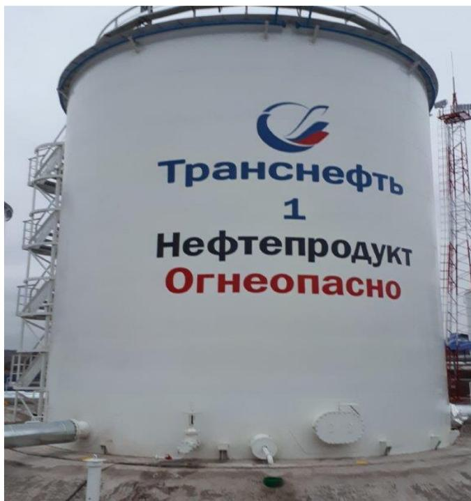
Рисунок 1 - Общий вид резервуара вертикального стального цилиндрического РВС-1000
