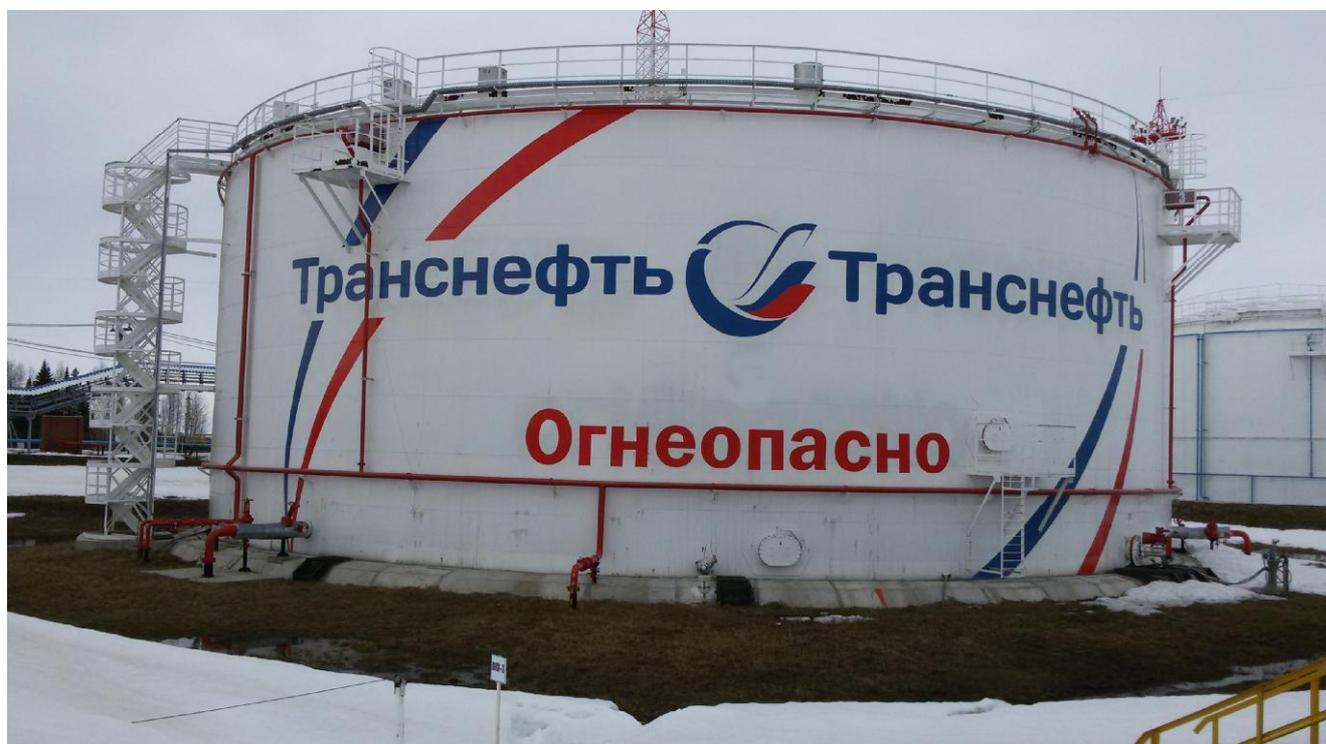
Рисунок 1 - Общий вид резервуара вертикального стального цилиндрического РВСП-3000
