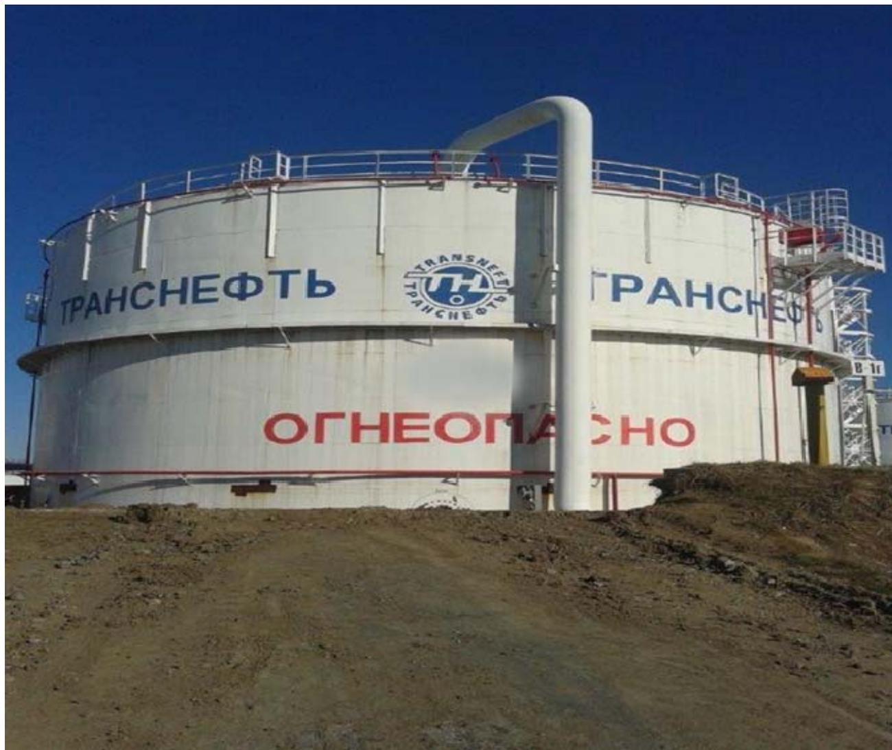
Рисунок 1 - Общий вид резервуара вертикального стального цилиндрического РВС-5000
