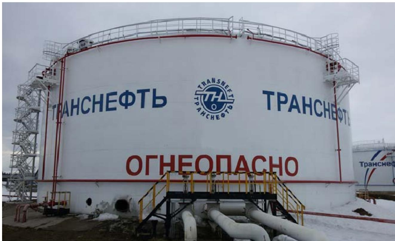
Рисунок 2 - Общий вид резервуара вертикального стального цилиндрического РВС-10000
