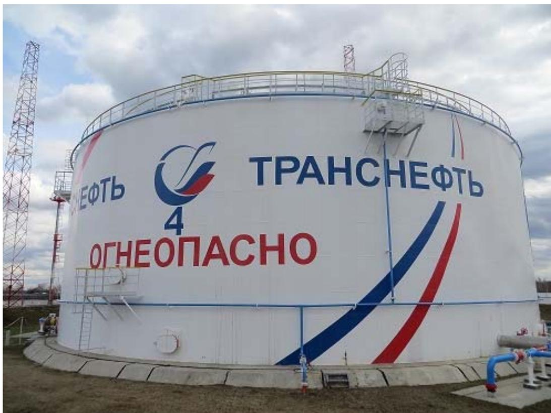
Рисунок 3 - Общий вид резервуара вертикального стального цилиндрического РВСП-10000
