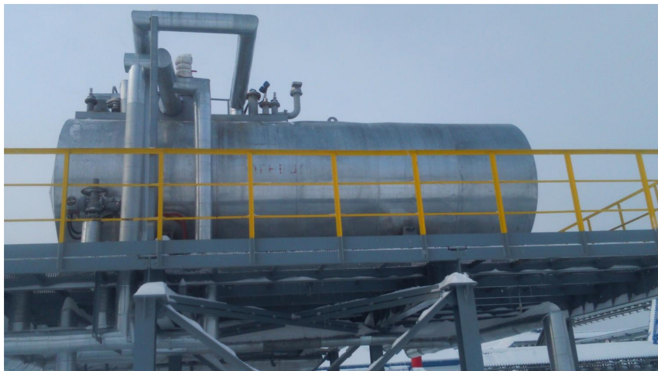
Рисунок 1 - Общий вид резервуара стального горизонтального цилиндрического РГС-20 (17+3)
