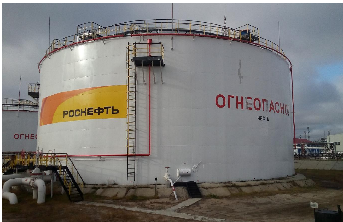
Рисунок 1 - Общий вид резервуара стального вертикального цилиндрического РВС-10000
