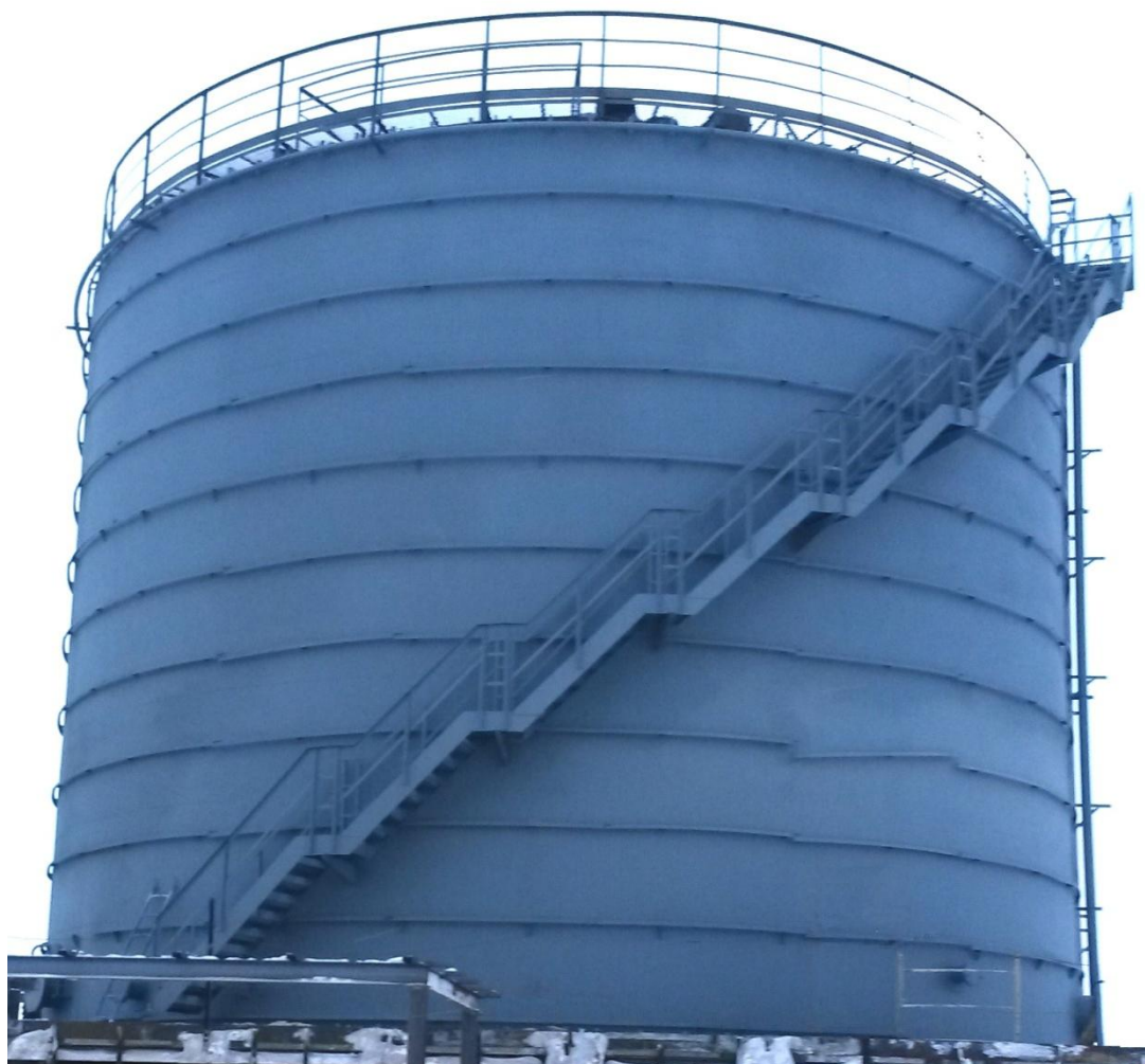
Рисунок 1 - Общий вид резервуара стального вертикального цилиндрического РВС-2000
