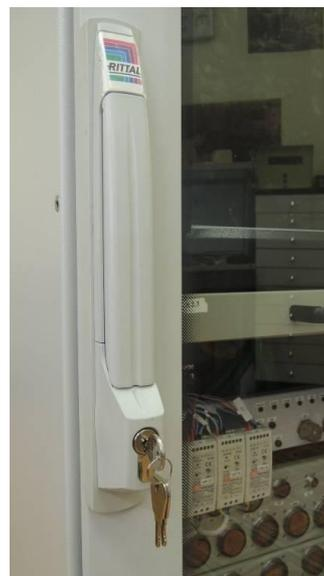
Рисунок 2 - Место пломбирования от несанкционированного доступа
