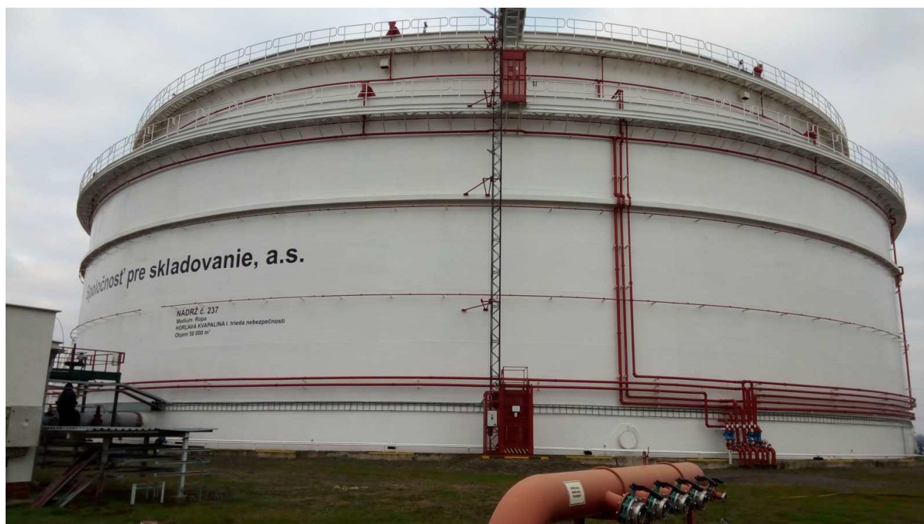
Рисунок 1 - Общий вид резервуара РВСПК-50000
