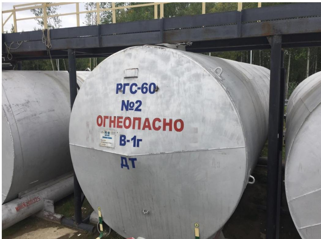
Рисунок 4 - Общий вид резервуара стального горизонтального цилиндрического РГС-60
