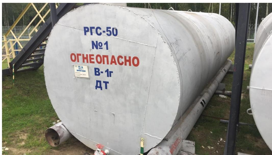
Рисунок 3 - Общий вид резервуара стального горизонтального цилиндрического РГС-50
