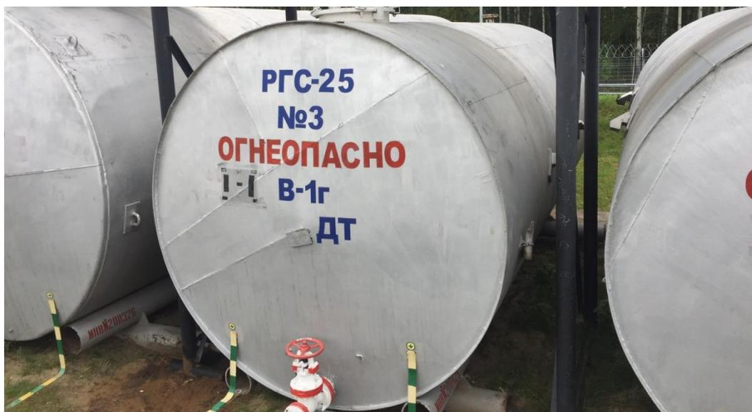
Рисунок 2 - Общий вид резервуаров стальных горизонтальных цилиндрических РГС-25
