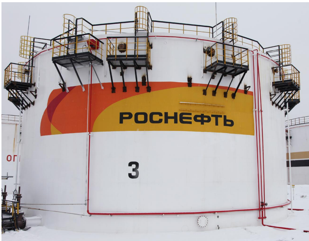
Рисунок 1 - Общий вид резервуара стального вертикального цилиндрического РВС-5000
