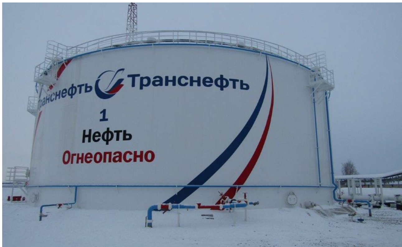
Рисунок 1 - Общий вид резервуара РВСП-10000
