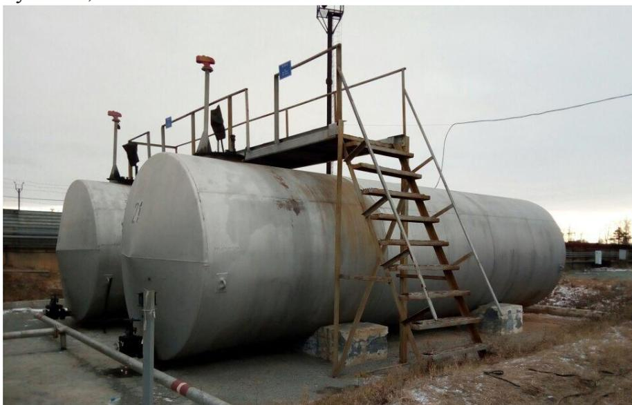
Рисунок 1 - Общий вид резервуара горизонтального стального цилиндрического РГС-55
