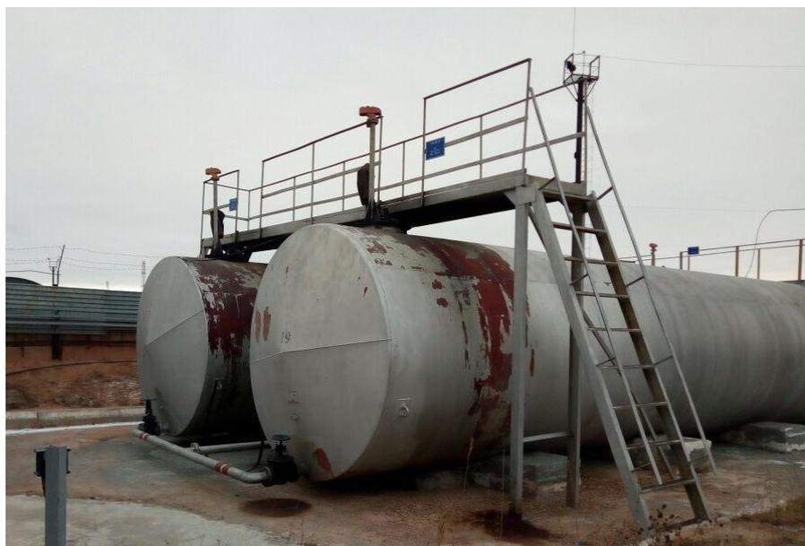
Рисунок 2 - Общий вид резервуара горизонтального стального цилиндрического РГС-65
