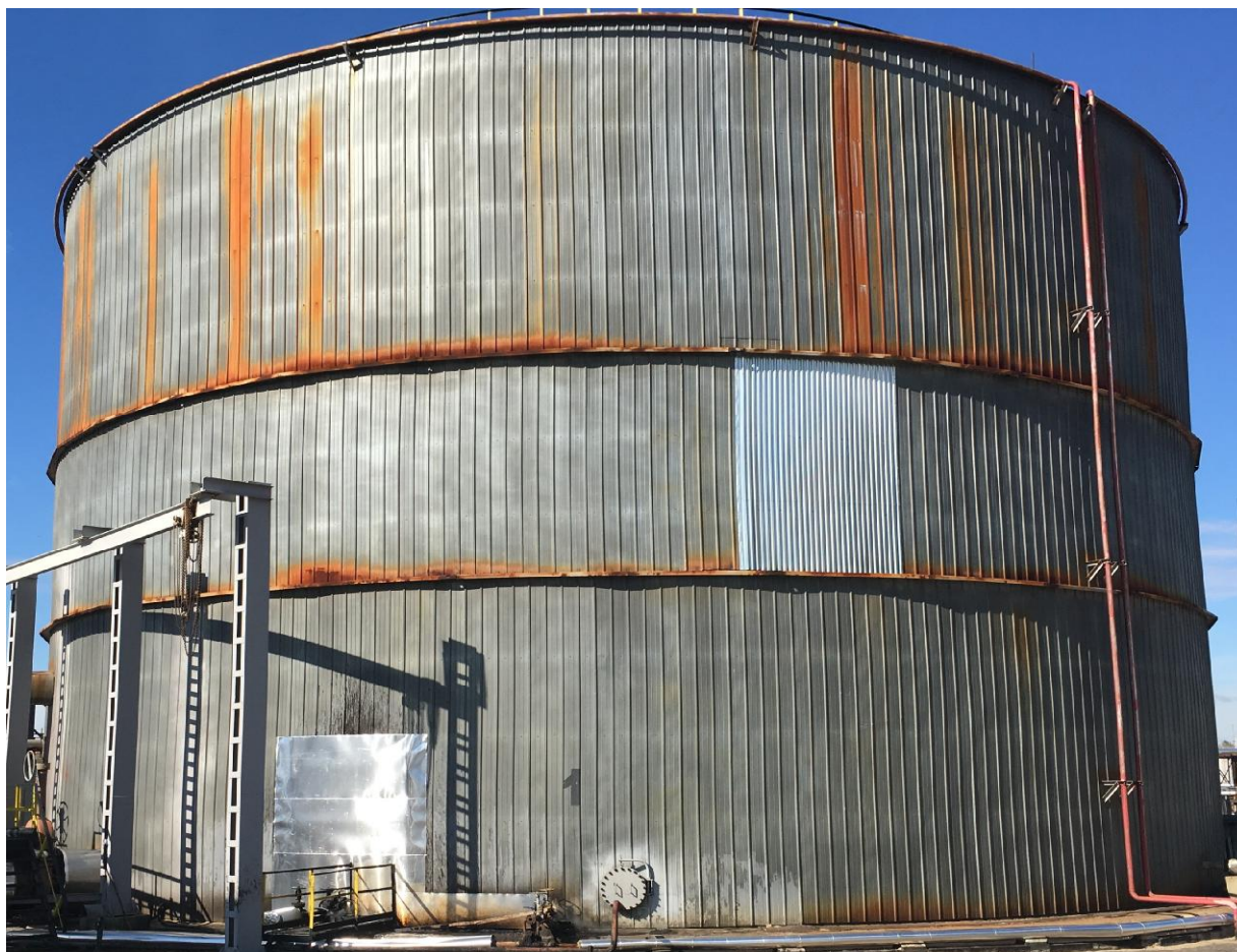
Рисунок 1 - Общий вид резервуара стального вертикального цилиндрического РВС-10000
