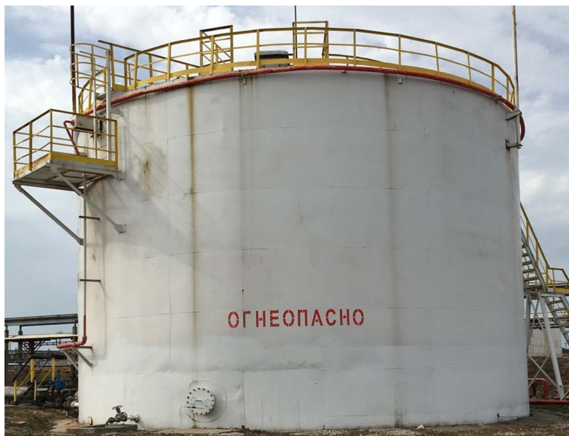
Рисунок 3 - Общий вид резервуара стального вертикального цилиндрического РВС-1000
