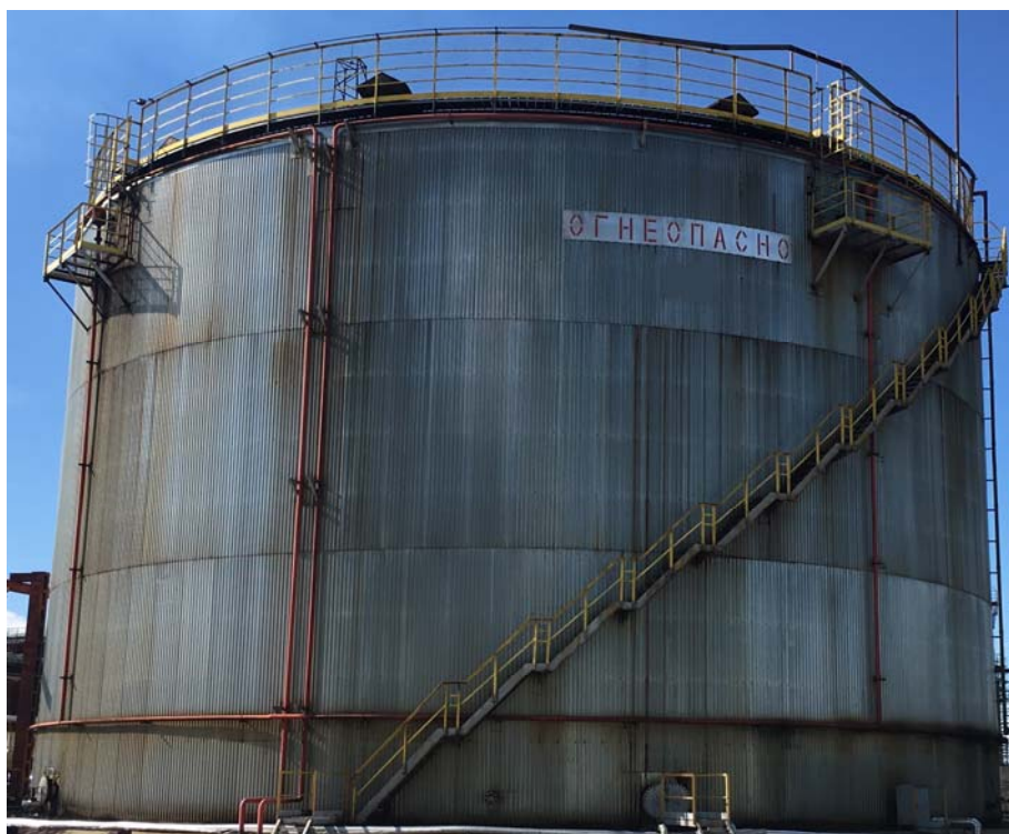
Рисунок 1 - Общий вид резервуара стального вертикального цилиндрического РВС-10000
