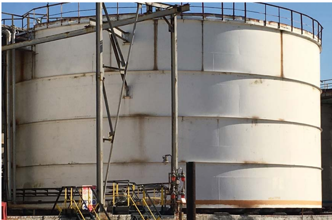
Рисунок 4 - Общий вид резервуара стального вертикального цилиндрического РВС-2000
