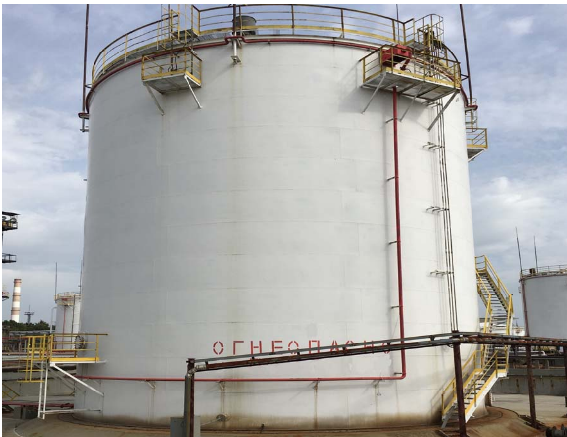
Рисунок 2 - Общий вид резервуара стального вертикального цилиндрического РВСП-3000
