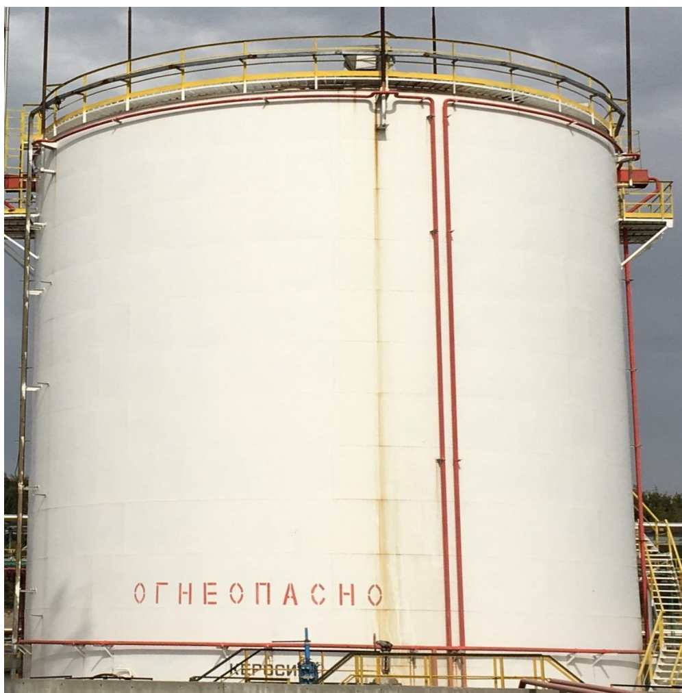
Рисунок 1 - Общий вид резервуара стального вертикального цилиндрического РВС-3000
