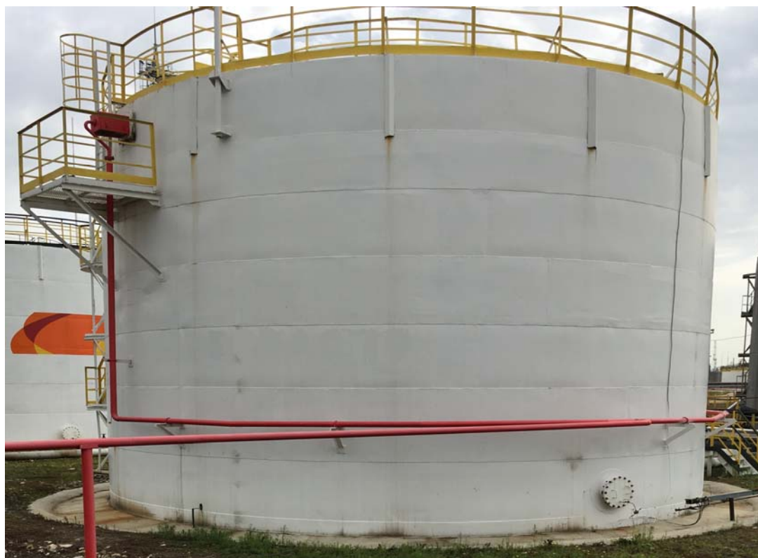
Рисунок 3 - Общий вид резервуара стального вертикального цилиндрического РВС-1000
