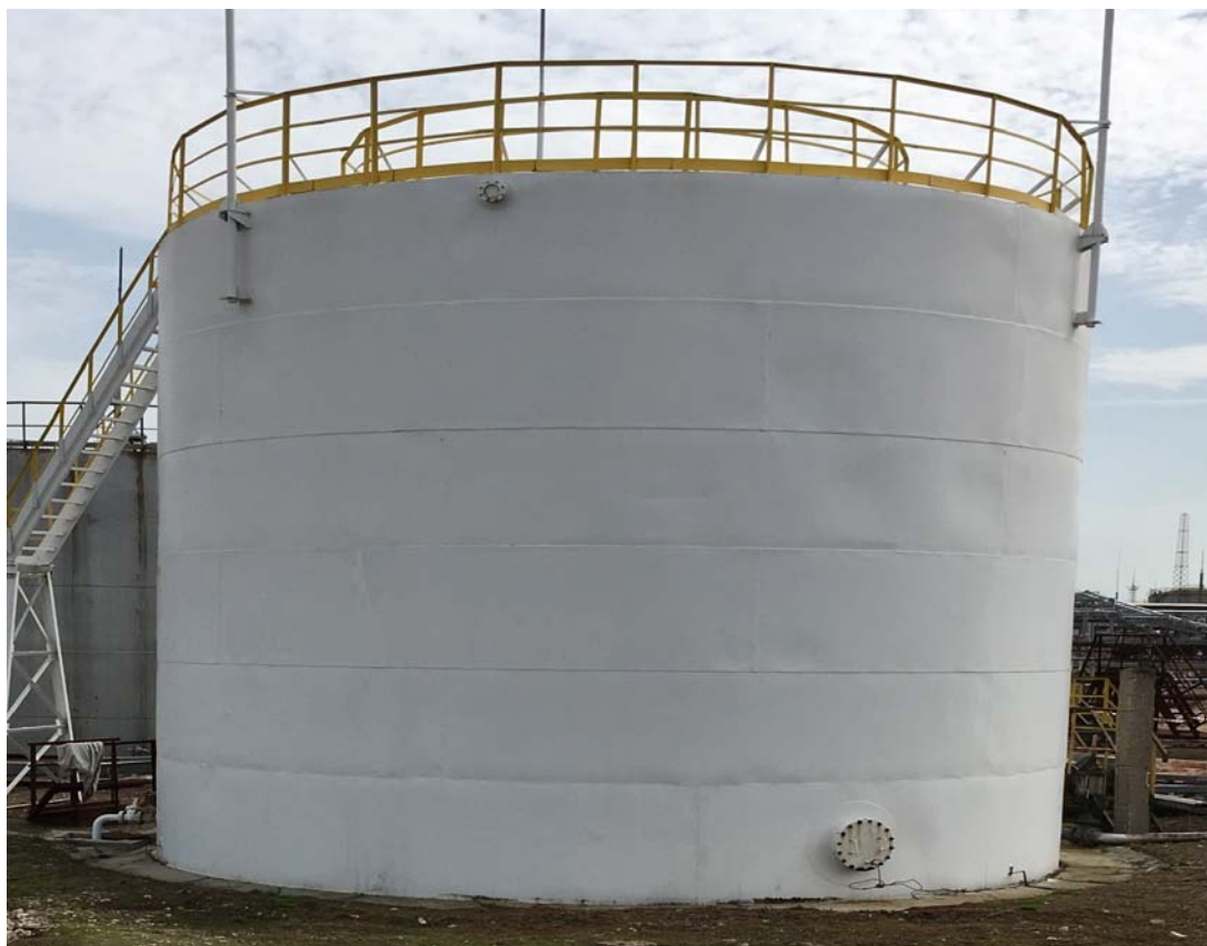
Рисунок 2 - Общий вид резервуара стального вертикального цилиндрического РВС-700
