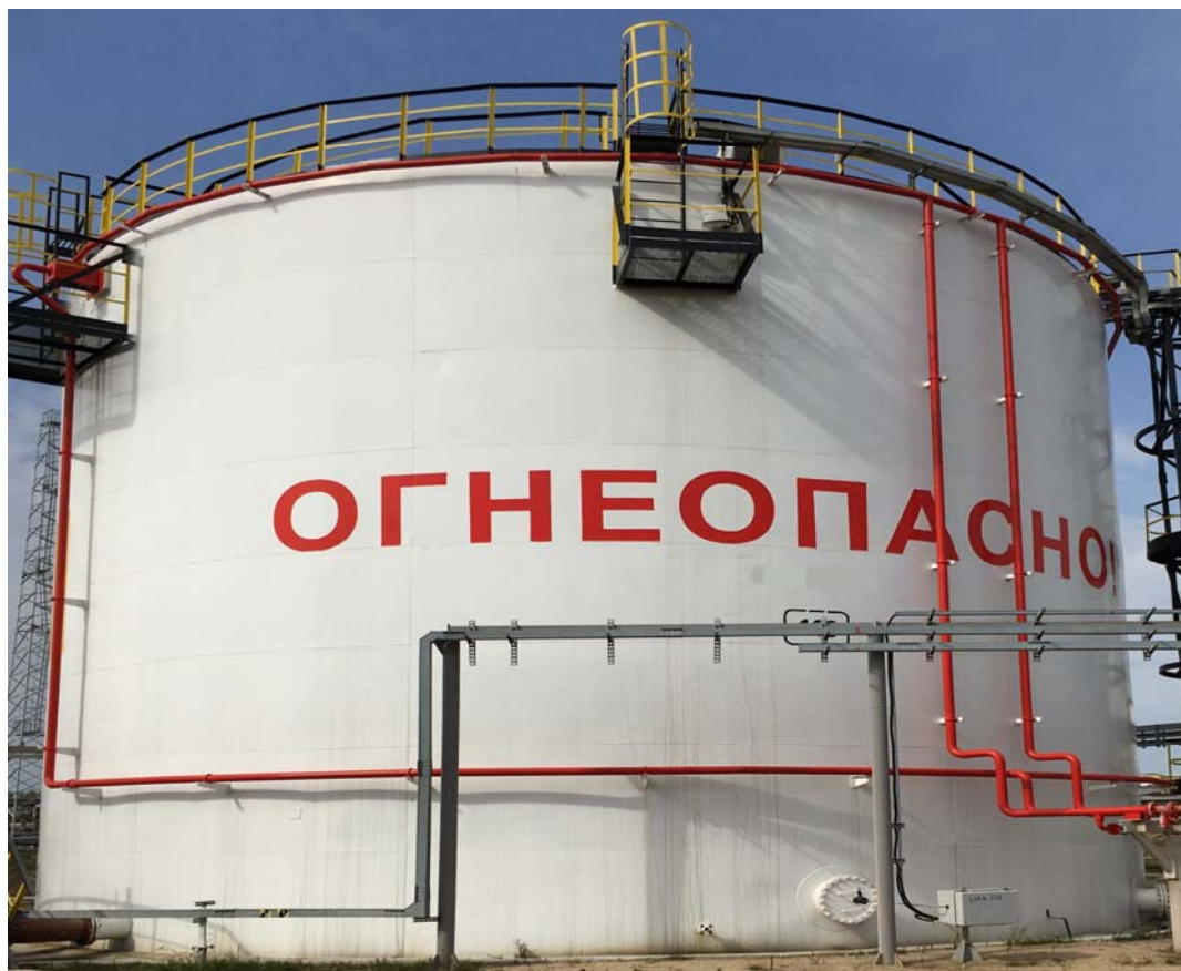
Рисунок 4 - Общий вид резервуара стального вертикального цилиндрического РВСП-2000
