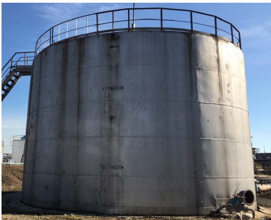
Рисунок 1 - Общий вид резервуара стального вертикального цилиндрического РВС-400
