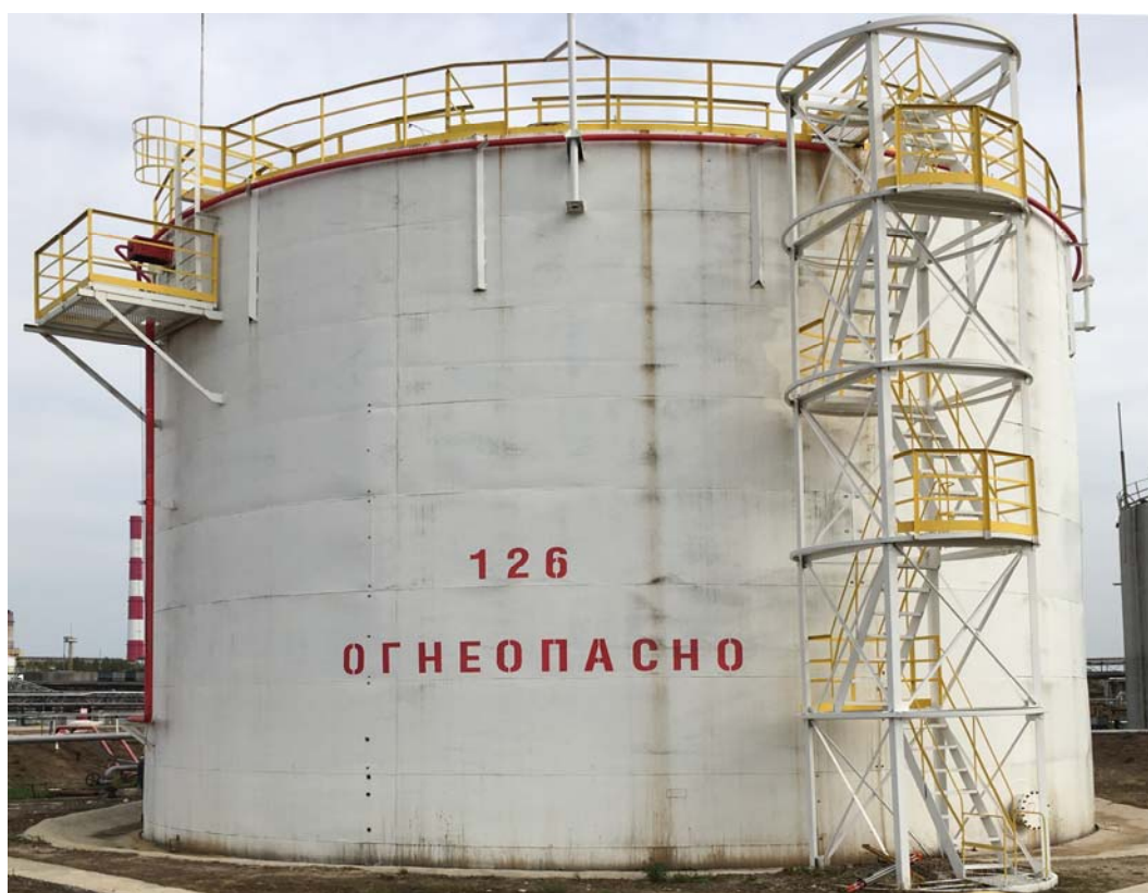
Рисунок 5 - Общий вид резервуара стального вертикального цилиндрического РВС-2000
