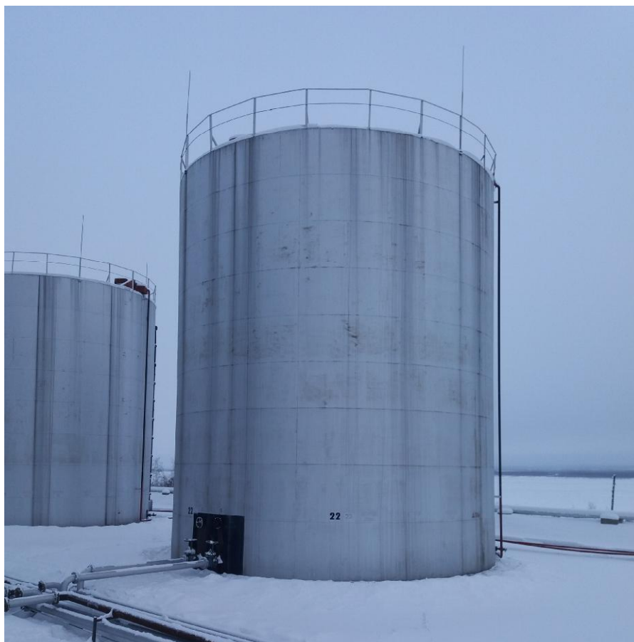
Рисунок 1 - Общий вид резервуара РВС-1000
