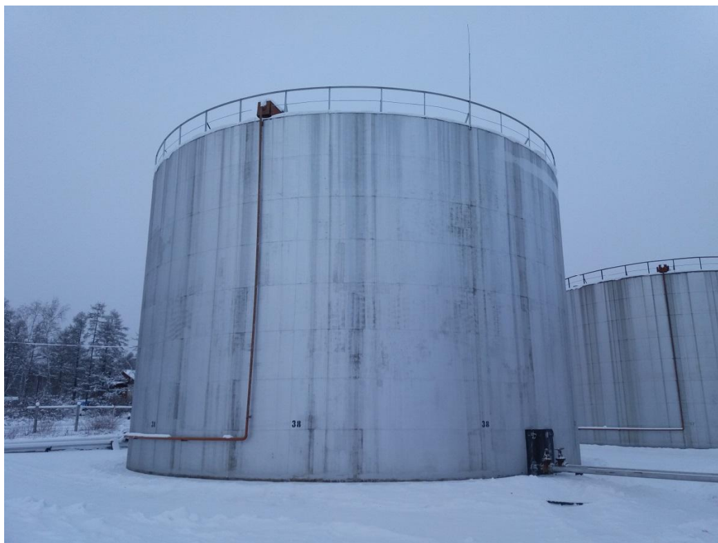
Рисунок 2 - Общий вид резервуара РВС-3000
