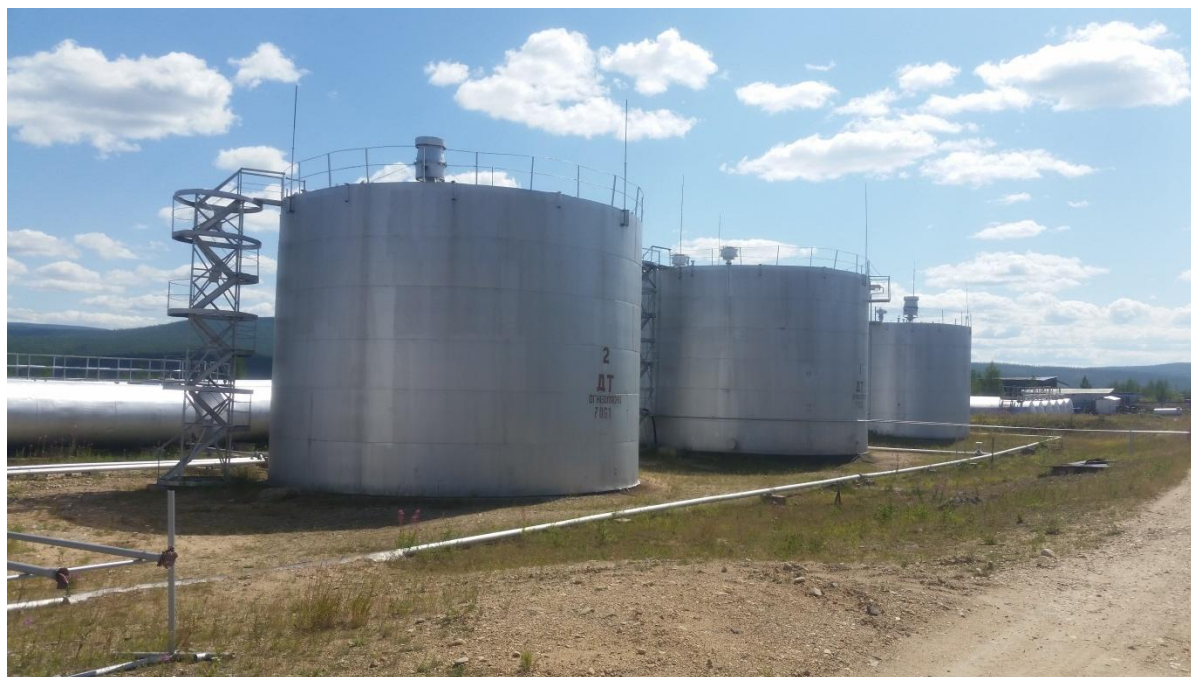
Рисунок 2 - Общий вид резервуара РВС-1000
