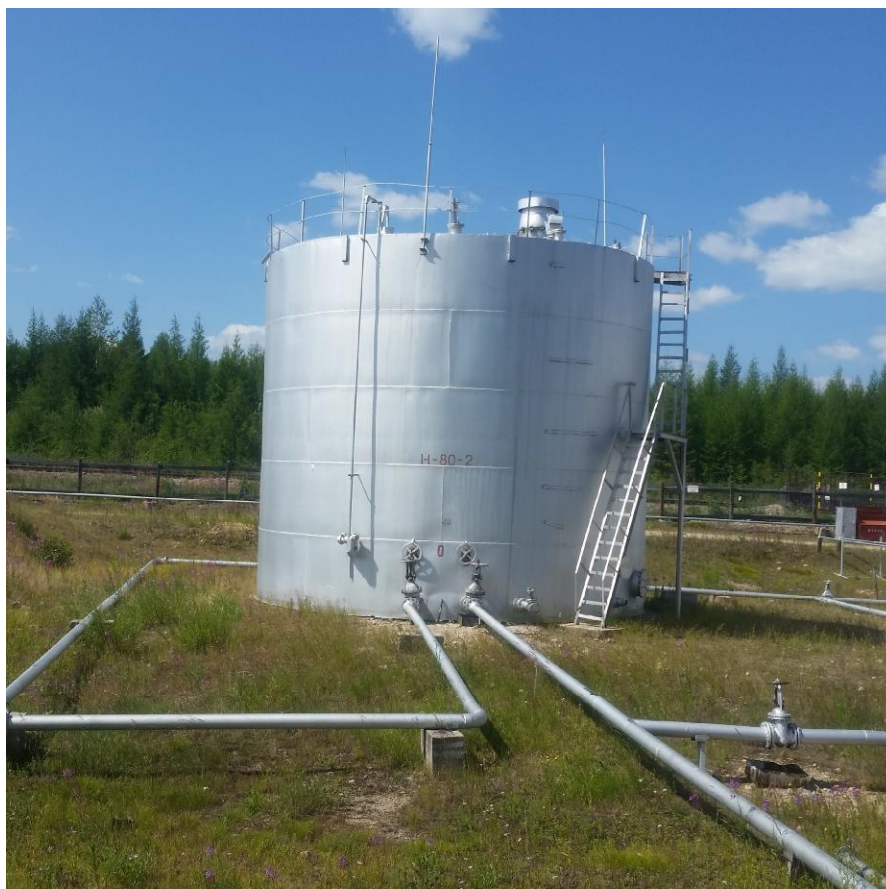
Рисунок 1 - Общий вид резервуара РВС-400
