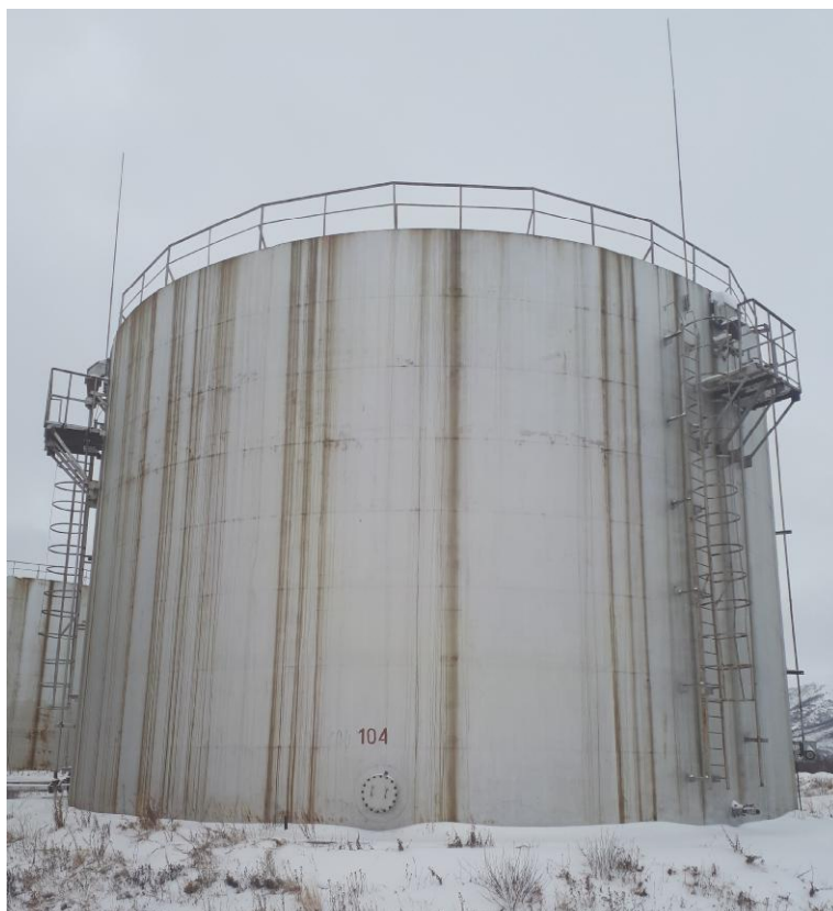
Рисунок 4 - Общий вид резервуара РВС-3000
