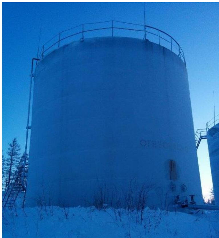
Рисунок 1 - Общий вид резервуара РВС-700
