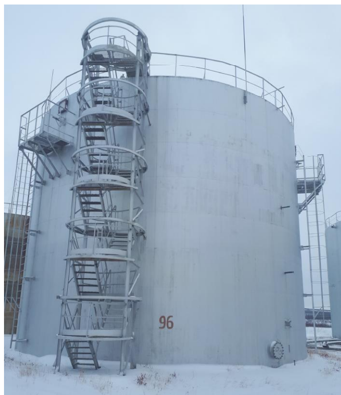
Рисунок 3 - Общий вид резервуара РВС-2000
