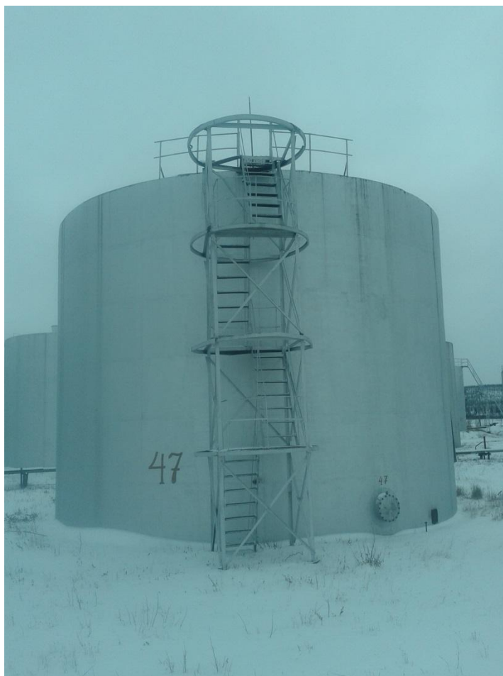
Рисунок 2 - Общий вид резервуара РВС-1000
