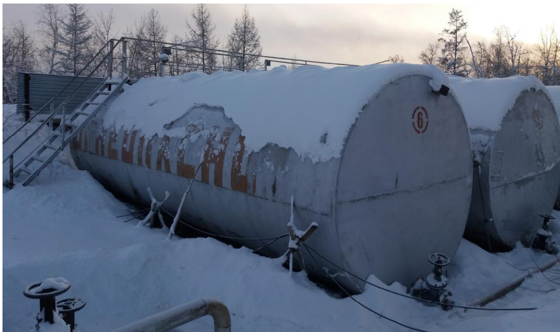
Рисунок 1 - Общий вид резервуара РГС-50
