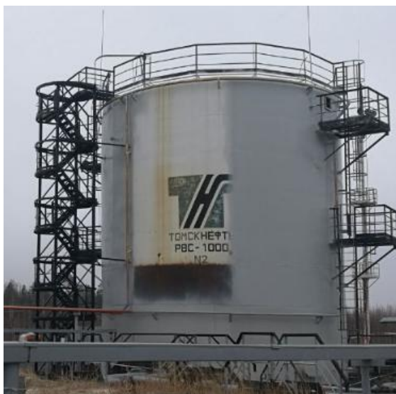
Рисунок 1 - Общий вид резервуаров РВС-1000
