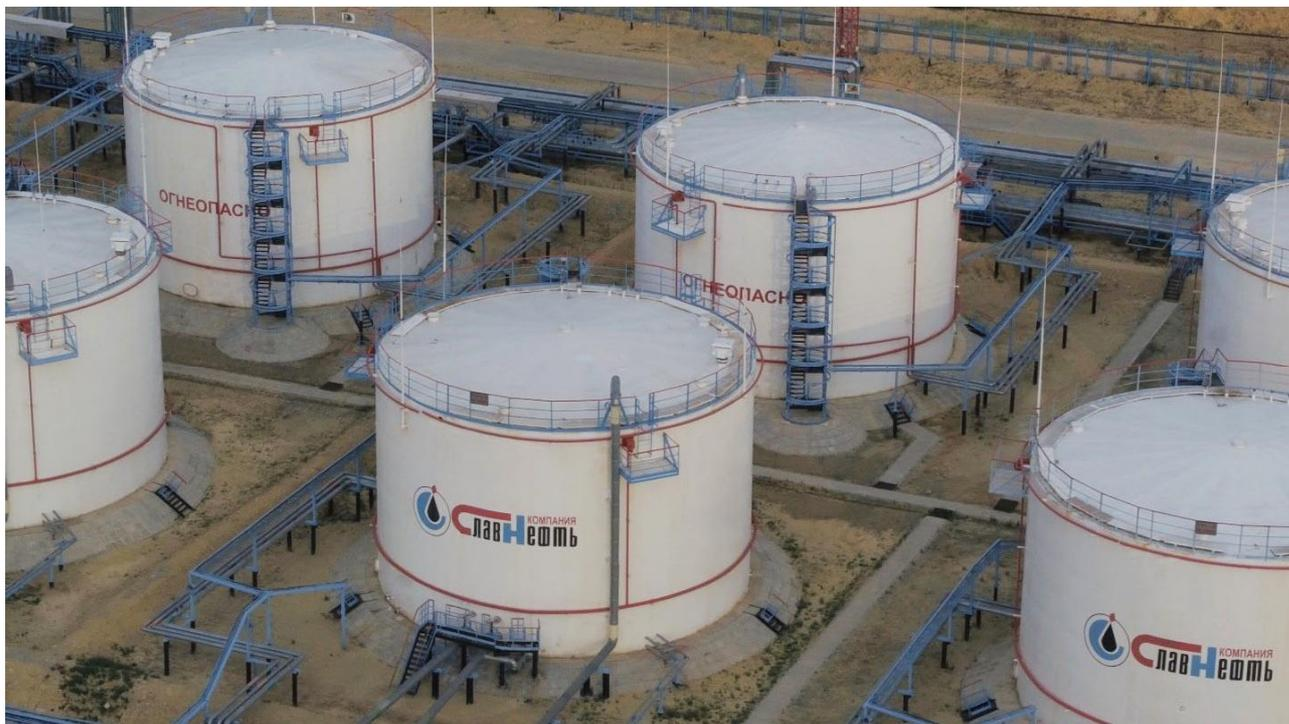
Рисунок 1 - Общий вид резервуаров вертикальных стальных цилиндрических РВС-3000
