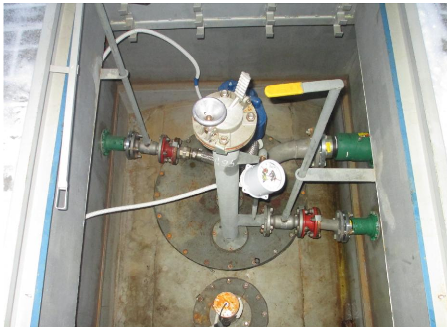
Рисунок 1 - Общий вид резервуара двустенного стального горизонтального двухкамерного для нефтепродуктов 2РТ-50 (35+15)
