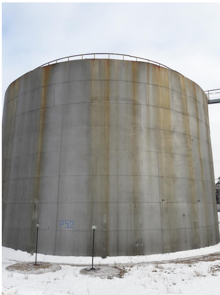
Рисунок 1 - Общий вид резервуара РВС-3000 № 5/2
