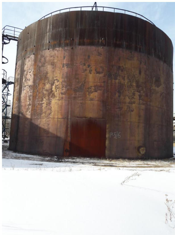
Рисунок 4 - Общий вид резервуара РВС-3000 № 5/6
