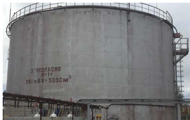
Рисунок 2 - Общий вид резервуара РВС-5000 № 8
