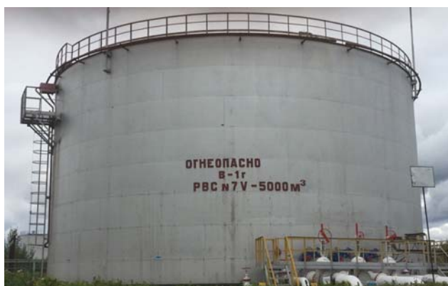
Рисунок 1 - Общий вид резервуара РВС-5000 № 7
