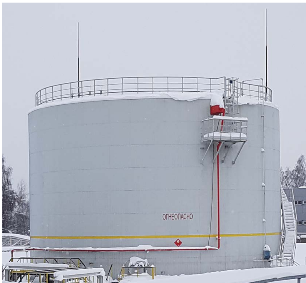
Рисунок 1 - Общий вид резервуара стального вертикального цилиндрического РВС-3000
