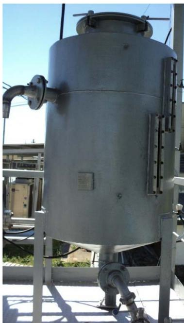
Рисунок 1 - Общий вид мерника металлического технического 1-го класса К7-ВМА
