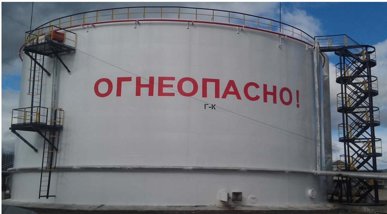
Рисунок 1 - Общий вид резервуара стального вертикального цилиндрического РВС-5000
