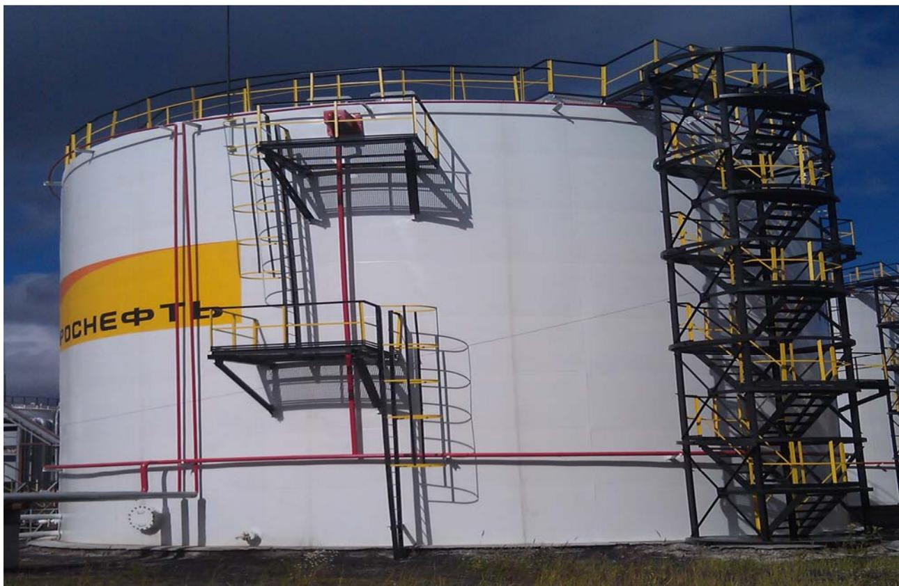
Рисунок 2 - Общий вид резервуара стального вертикального цилиндрического РВС-2000
