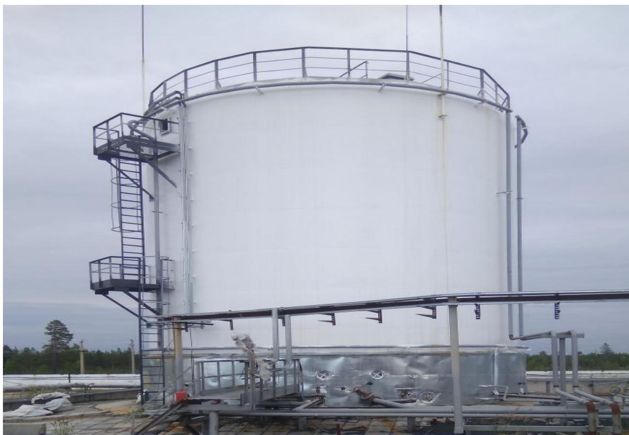
Рисунок 3 - Общий вид резервуара стального вертикального цилиндрического РВС-1000
