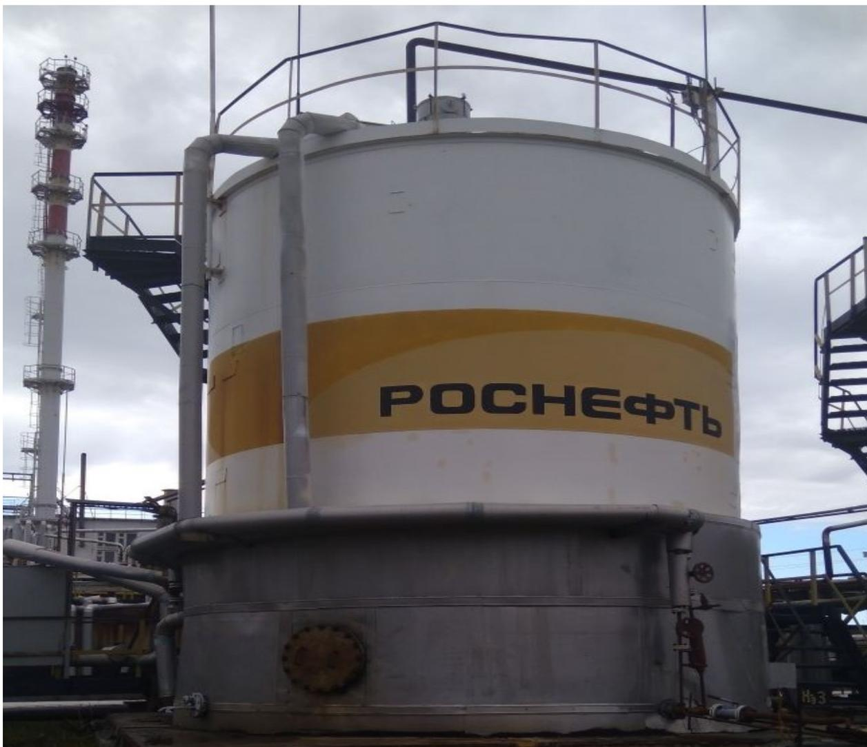
Рисунок 6- Общий вид резервуара стального вертикального цилиндрического РВС-100
