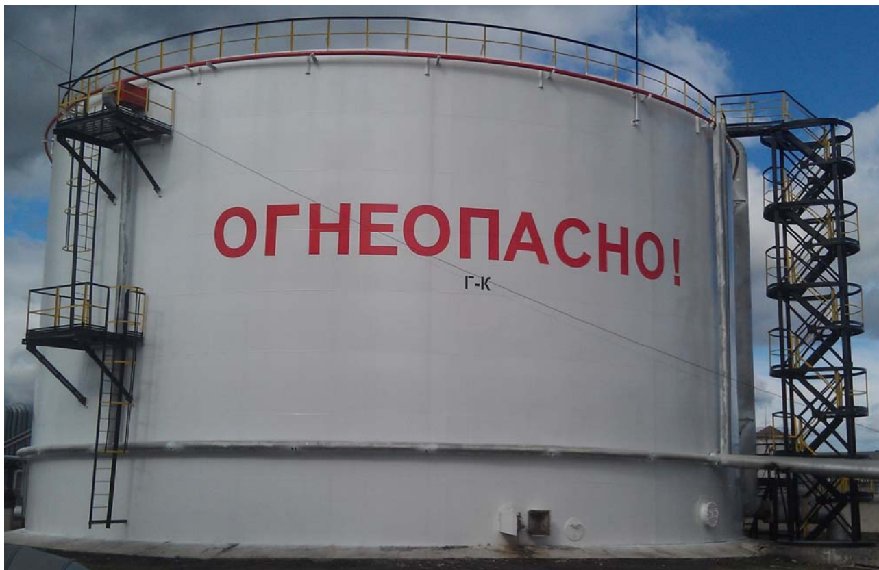
Рисунок 1 - Общий вид резервуара стального вертикального цилиндрического РВС-5000
