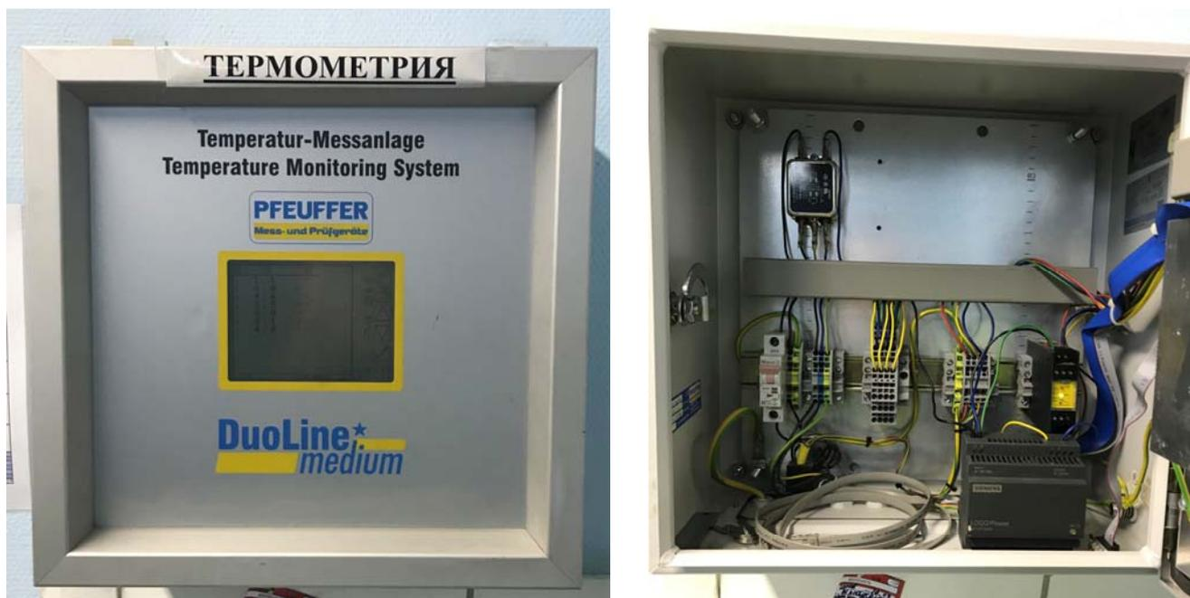
Рисунок 1 - Общий вид измерительно-управляющего блока системы
