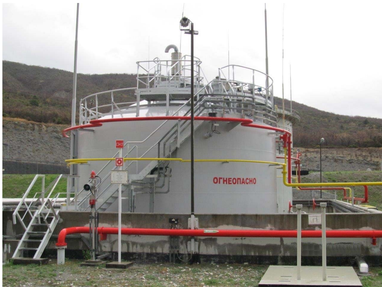
Рисунок 1 - Общий вид резервуара РВС-200
