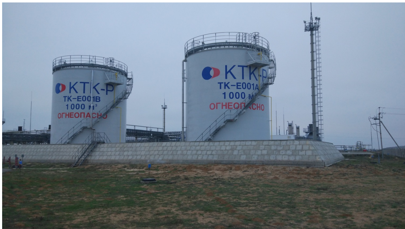
Рисунок 1 - Общий вид резервуаров РВС-1000
