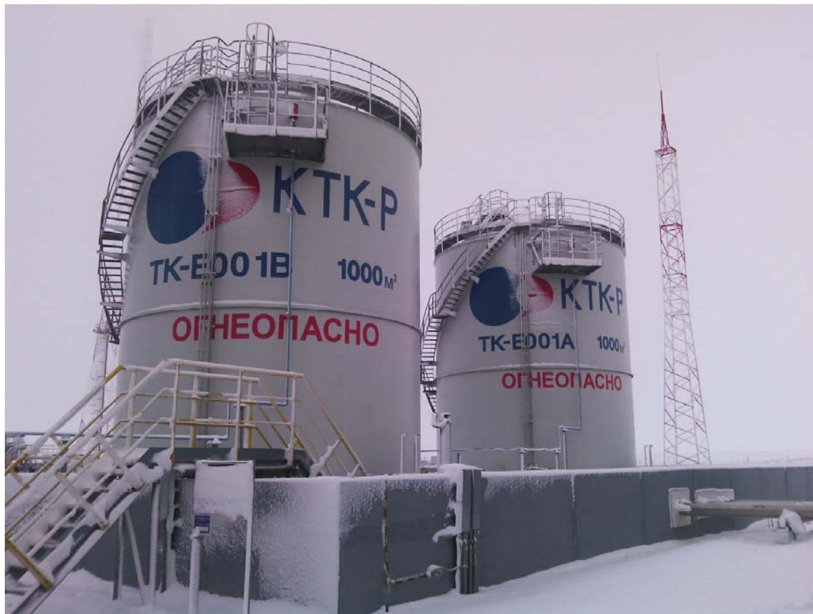
Рисунок 1 - Общий вид резервуара РВС-1000
