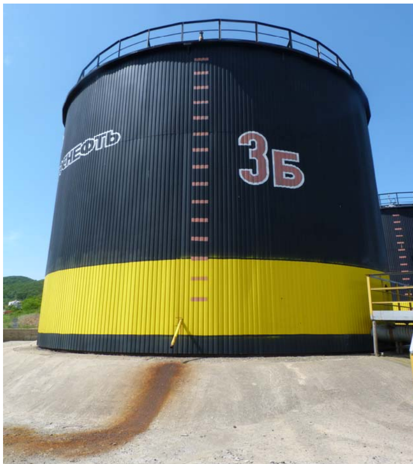
Рисунок 1 - Общий вид резервуара вертикального стального цилиндрического РВС-700
