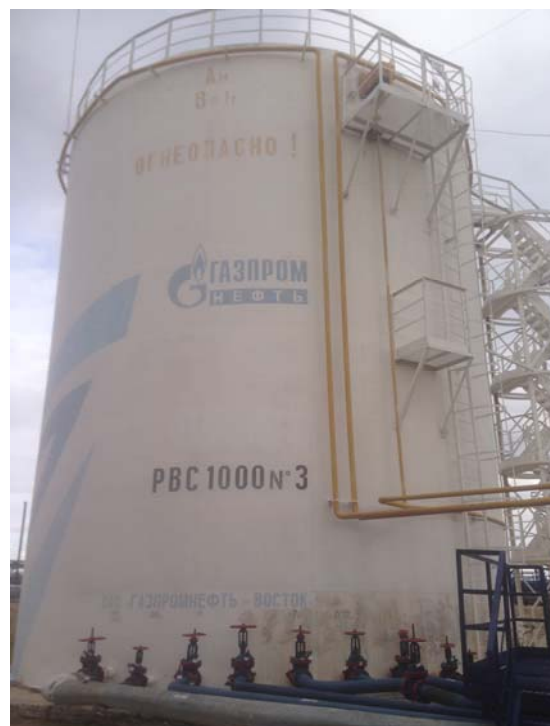
Рисунок 2 - Общий вид резервуара РВС-1000
