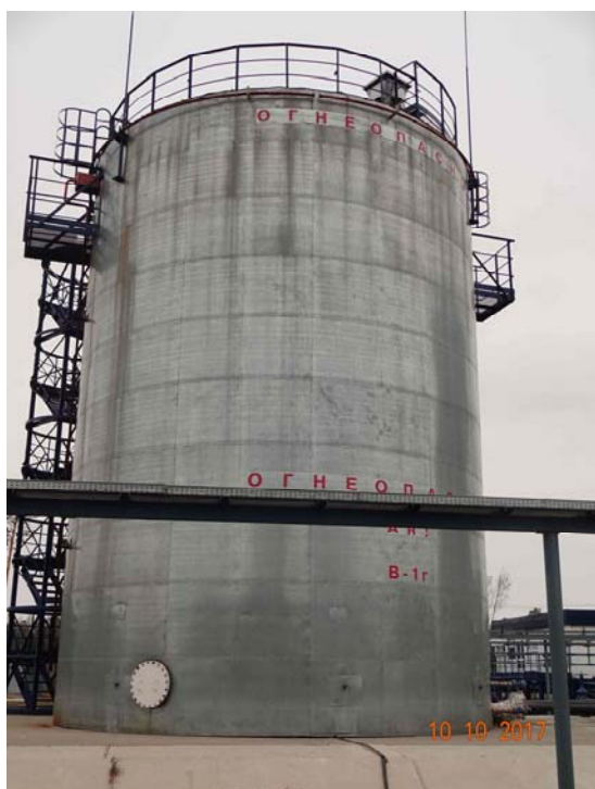
Рисунок 1 - Общий вид резервуара РВС-700
