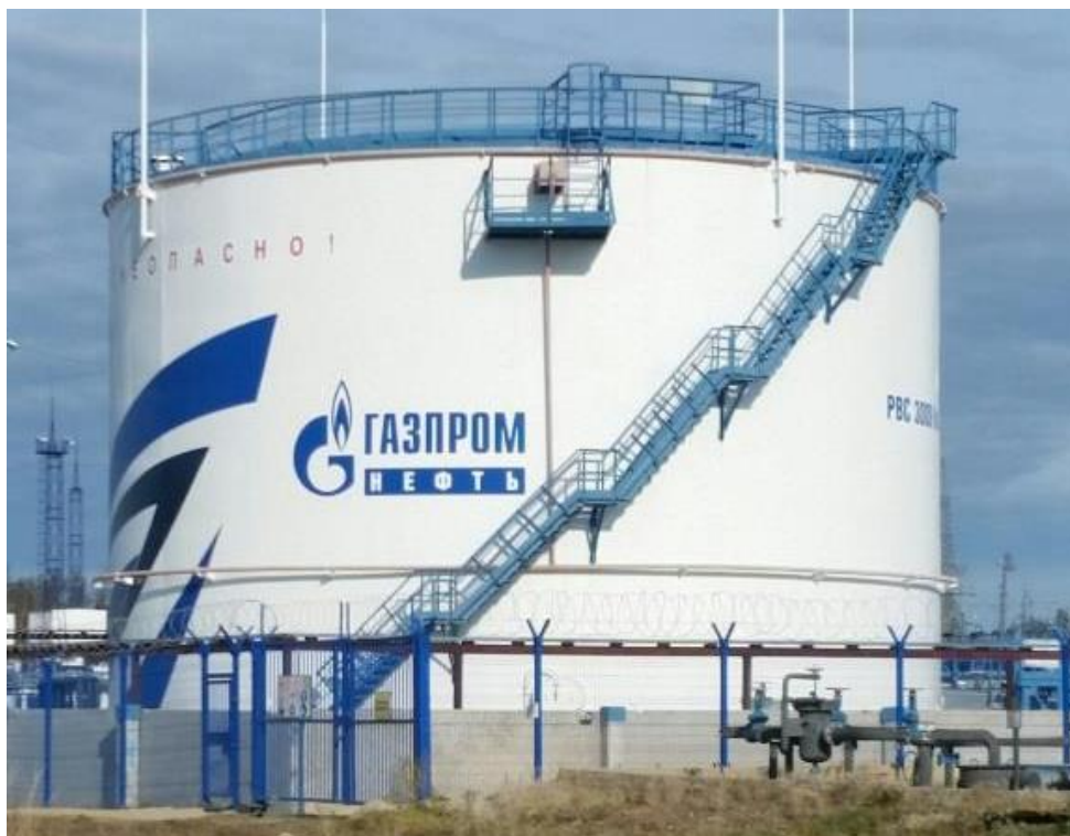
Рисунок 3 - Общий вид резервуара РВС-3000
