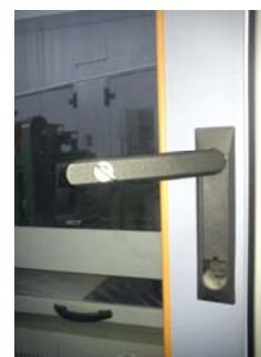
Рисунок 6 - Внешний вид замка на дверце стойки управления
