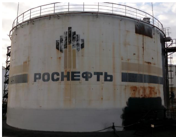
Рисунок 1 - Общий вид резервуара
