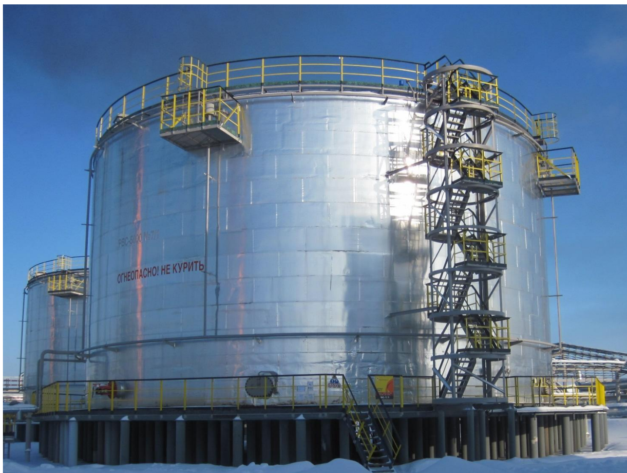
Рисунок 1 - Общий вид резервуара стального вертикального цилиндрического РВС-5000
