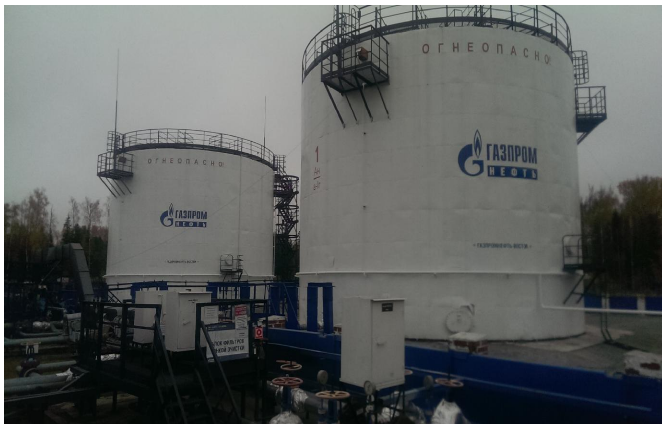
Рисунок 1 – Общий вид резервуара
