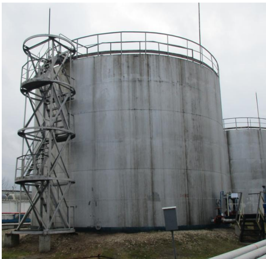
Рисунок 1 - Общий вид резервуаров вертикальных стальных цилиндрических РВС-1000
