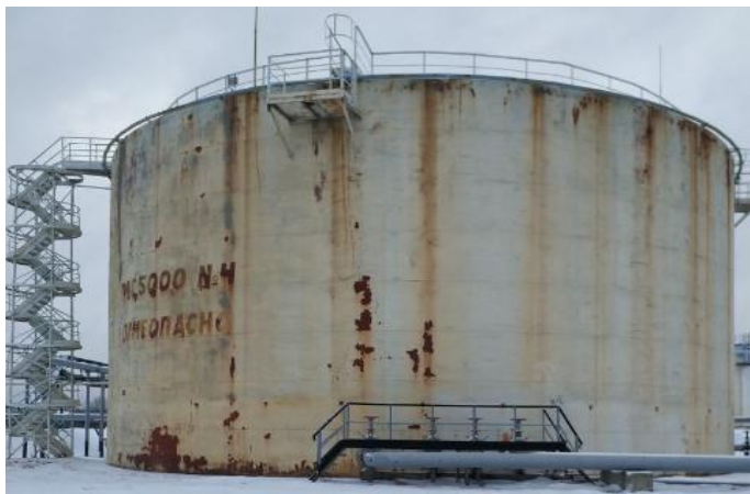
Рисунок 1 - Общий вид резервуара
