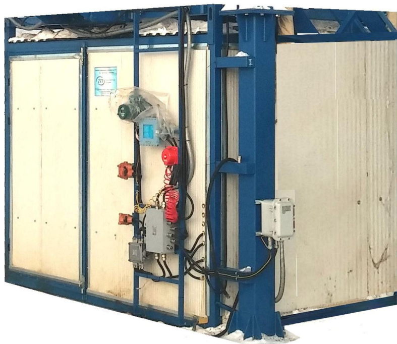
Рисунок 4 – АТНК-XXXXX Исполнение в блок боксе с обогревом Все внешние приборы и соединительные коробки имеют взрывозащищенное исполнение и сертификаты
