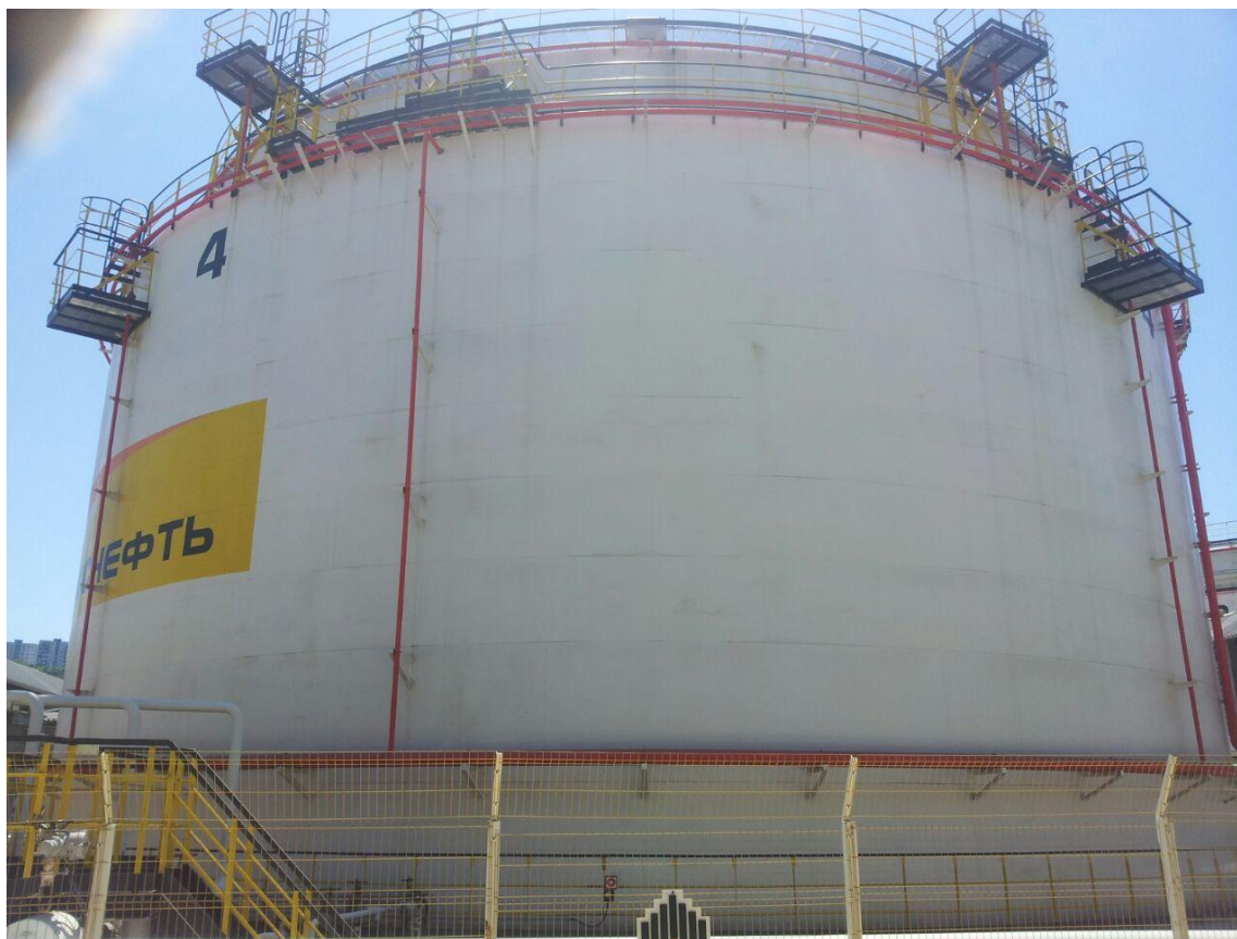
Рисунок 1 - Общий вид резервуаров с защитной стенкой PVC-10000
